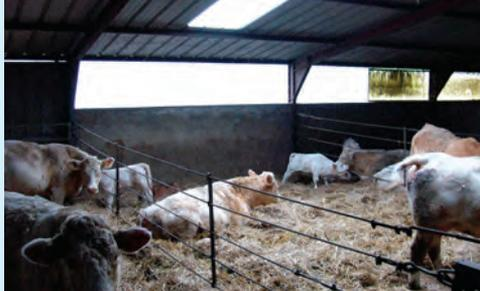
Bardage vue intérieure : à gauche les plaques translucides perforées restent propre. à droite sur les anciennes plaques la poussière colle avec la condensation.
